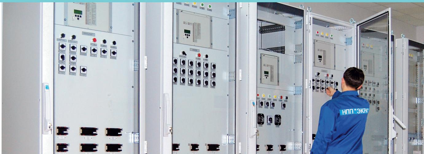
Серия шкафов ШЭ2607 релейной защиты и автоматики подстанционного оборудования напряжением 6–220 кВ на базе микропроцессорных терминалов серий БЭ2704 и БЭ2502.
